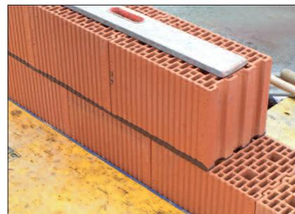
Die Mörtelaufbringung erfolgt entweder im Tauchverfahren (ca. 0,5 cm tief) oder mittels Auftragswalze. Nach jeder zweiten Lagerfuge müssen an den Stellen der späteren Innenwandanschlüsse V4A-Flachstahllanker eingebaut werden.
