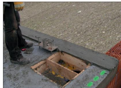
Vor Beginn der Mauerarbeiten muss auf der Bodenplatte oder Kellerrohdecke gegen aufsteigende Feuchtigkeit eine horizontale Feuchtigkeitssperre aufgebracht werden. Daraufhin wird mittels Nivelliergerät, Anlegehilfe und Alulatte ein vollflächiges Mörtelband als Höhenausgleich (mind. 1 cm BRENNER – Anlegemörtel) aufgebracht.
