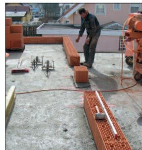
Von den Ecken aus beginnend, wird nach ausreichender Festigkeit des Mörtelbettes mit Hilfe von Schnur, Wasserwaage und Gummihammer die erste Ziegelschar verlegt. Für die exakte Ebenflächigkeit jedes einzelnen Ziegels muss gesorgt werden.
